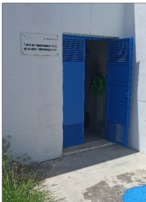
Figura 41. Puerta de acceso al depósito Monte Lope
