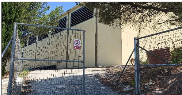
Figura 24. Acceso al perímetro exterior del depósito Nuevo El Calvario.
