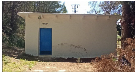
Figura 5. Exterior de Sondeo La Maleza.
