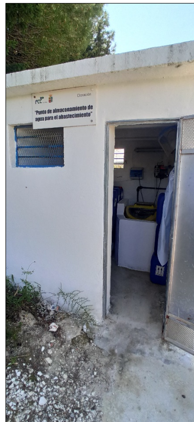
Figura 11. Exterior caseta exterior de cloración del agua procedente del sondeo La Maleza.
