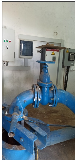
Figura 6. Interior del Sondeo La Maleza.
