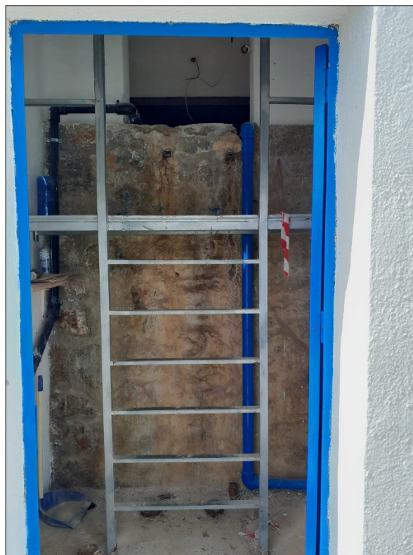
Figura 44. Interior deposito Villarabajo 1.
