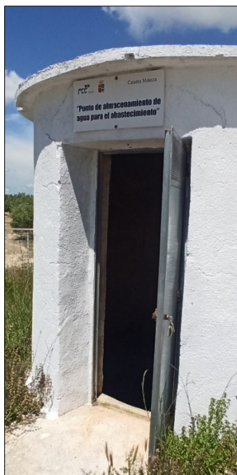
Figura 18. Exterior arqueta de unión de manantial y sondeo La Maleza.
