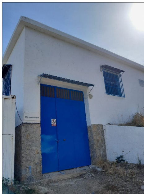
Figura 14. Exterior de ETAP Sierra Grande.
