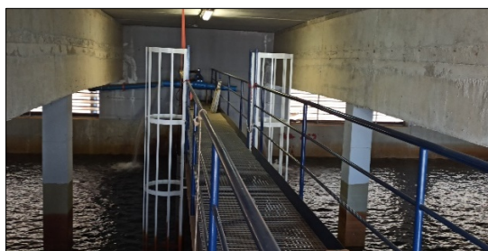
Figura 31. Pasarela de inspección de los vasos del depósito nuevo El Calvario
