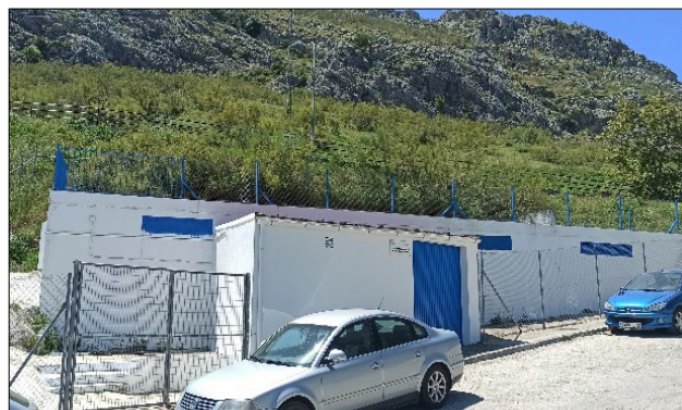
Figura 34. Exterior depósito El Portillo
