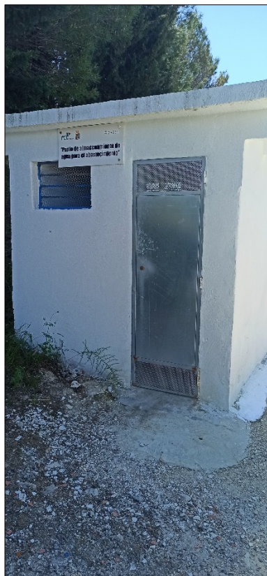
Figura 10. Exterior caseta exterior de cloración del agua procedente del sondeo La Maleza.
