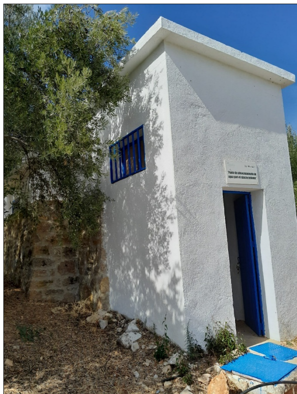
Figura 43. Exterior deposito Villarabajo 1.
